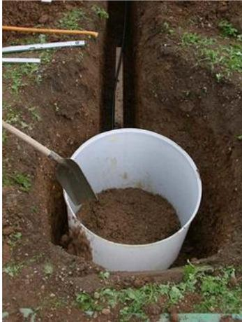
Abbildung 11.15. Einbau Lysimeter Schwertberg
